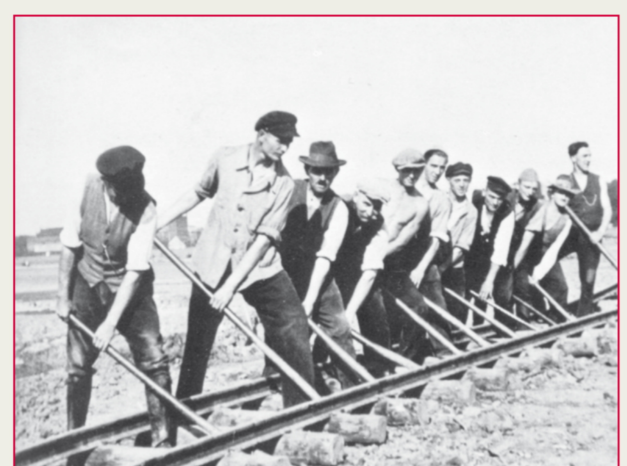
Verlegung von Schienen.
