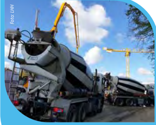
Neubau Grundschule Mühlenberg: Die Bauarbeiten am neuen Schulgebäude verlaufen nach Plan.
