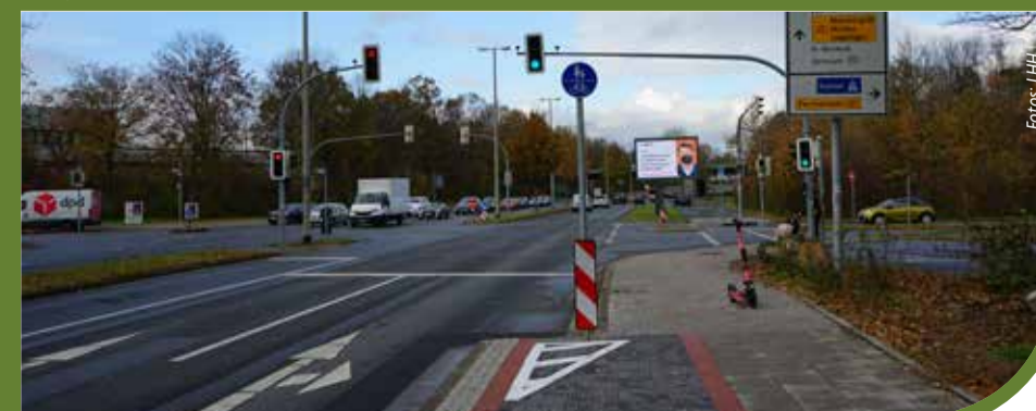
Foto unten: Die Neugestaltung des Kreuzungsbereichs an der Bornumer Straße – Beckstraße-Auffahrt B 65 – erfolgt voraussichtlich ab Ende 2023/ 2024.
