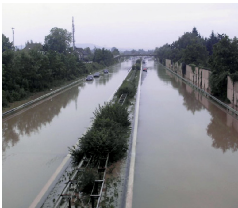
A 73 bei Baiersdorf / Bayern nach Starkregen
