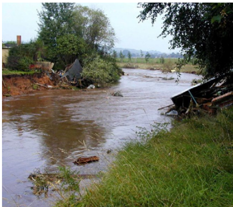
Schäden am Lungwitzbach / Sachsen nach Hochwasser 2002
