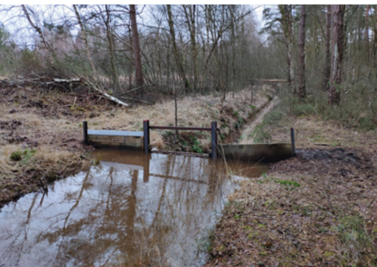
Foto aus dem Februar 2020: Das Wehr staut den Bannsee-graben. Hinter dem Wehr ist der tief in den Moorkörper eingeschnittene Grabenverlauf zu erkennen.
