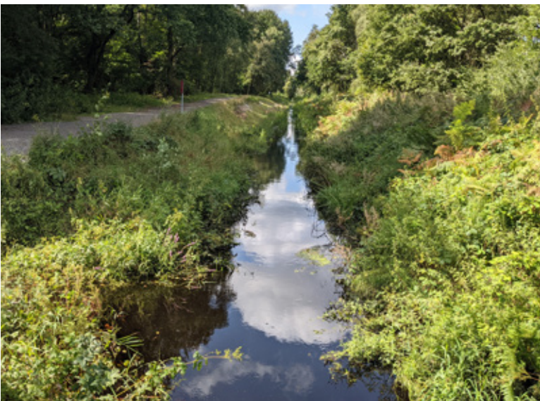
Die Sohlgleite im August 2021: Das Bauwerk ist gut eingegrünt. Das Wasser strömt etwa 20 Zentimeter hoch in der Mittelwasser- rinne. Links ist die Böschungaufweitung zu erkennen, durch die Hochwässer schadlos abfließen können.
