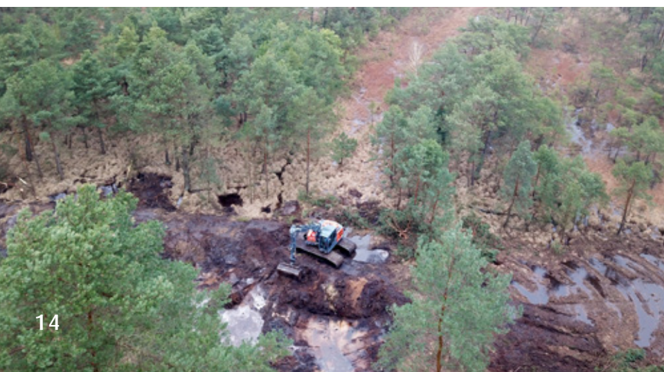
Bau einer Torfverwallung im Süden des Otternhagener Moores (gelber Punkt)
