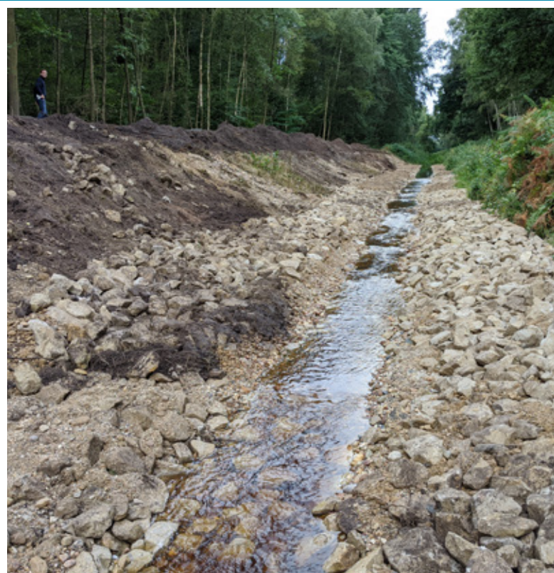
Bau der Sohlgleite im September 2020 zur Verringerung des Wasserabflusses
