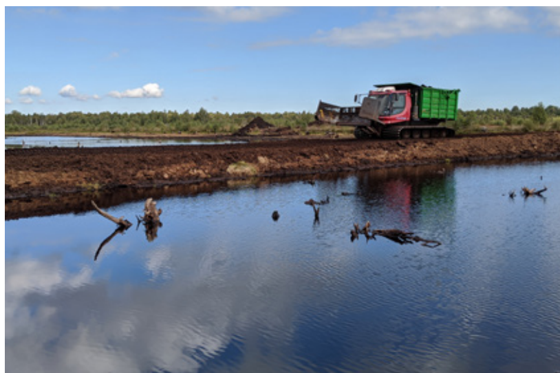
Die Verwallungen in überstauten Flächen können nur mit Spezialmaschinen umgesetzt werden, hier ein Pistenbull mit Transportmulde und Frontschild.
