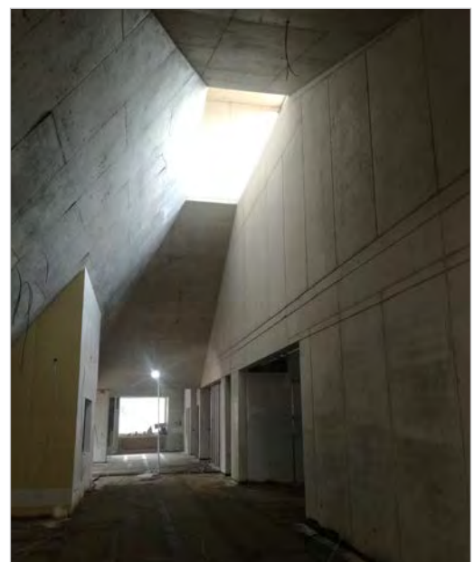
Blick durch das Foyer im Bauzustand (LHH)
