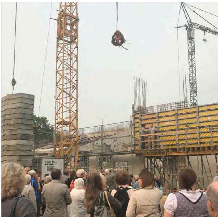
Im Oktober 2017 wurde ein Richtfest zum Neubau STZ gefeiert. (LHH)
