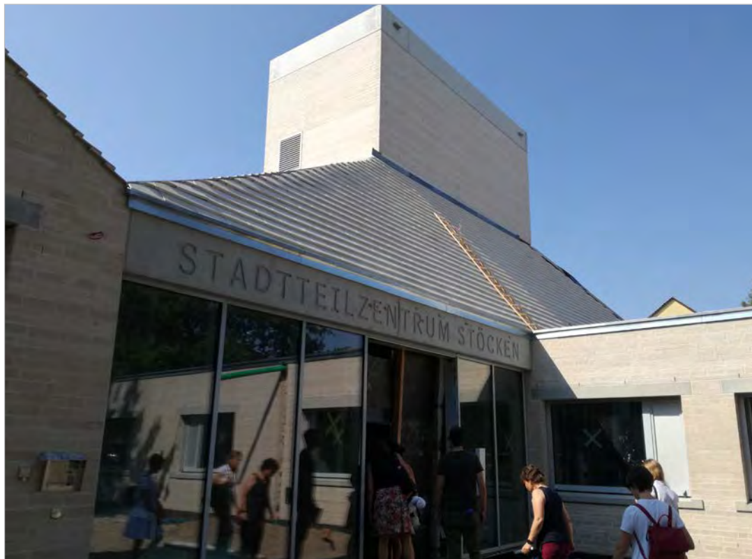
Im August 2019 ist der Eingangsbereich vom Neubau schon gut erkennbar (LHH)
