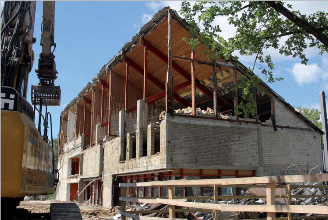
Abbrucharbeiten am FZH Stöcken im Sommer 2016 (LHH)
