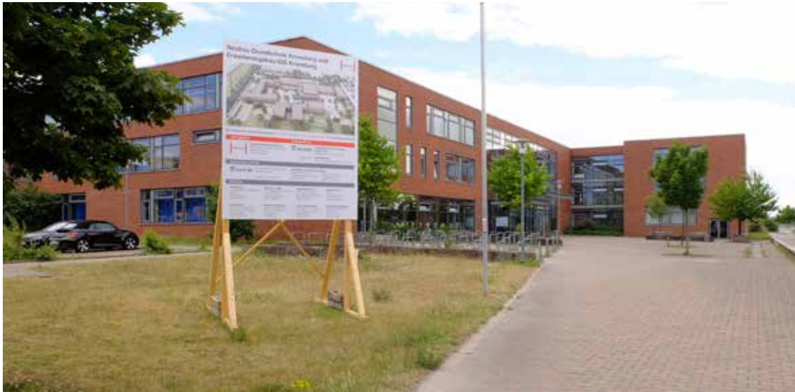
Abb. 51: Im Ausbau befindliche IGS Kronsberg, Bemerode
