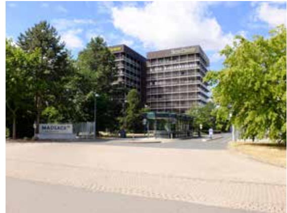
Abb. 46: Madsackgebäude, August-Madsack-Straße, Bemerode
