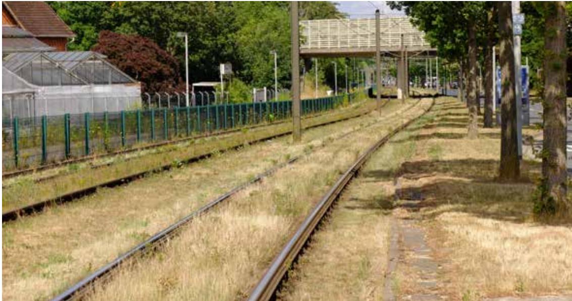
Abb. 63: Stadtbahntrasse entlang der Bemeroder Straße, Bemerode
