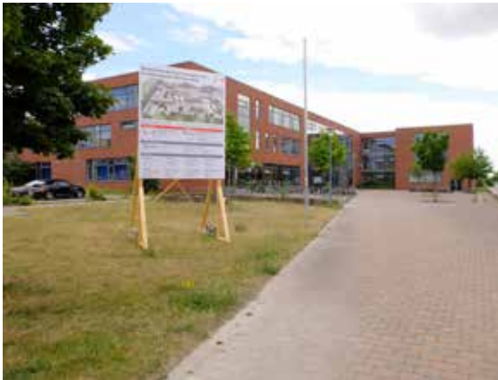
Abb. 41: Im Ausbau befindliche IGS Kronsberg, Bemerode
