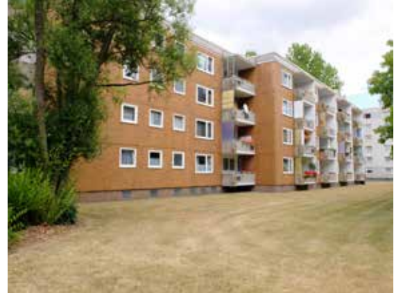
Abb. 22: Wohngebäude in der Anecampstraße, Bemerode
