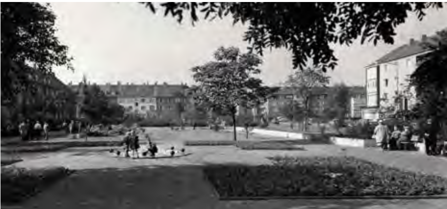
69 Schünemannplatz in Hannover – Umbau eines ehemaligen ‚Schmuckplatzes‘ in eine vielfältig nutzbare Anlage, 1964“
