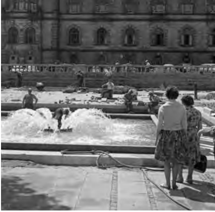
27 Bauarbeiten am Trammplatz, 1961
