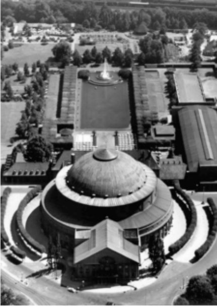
30 Luftbild, Die Gartenseite der Stadhalle – Zustand vor der Umplanung, 1960
