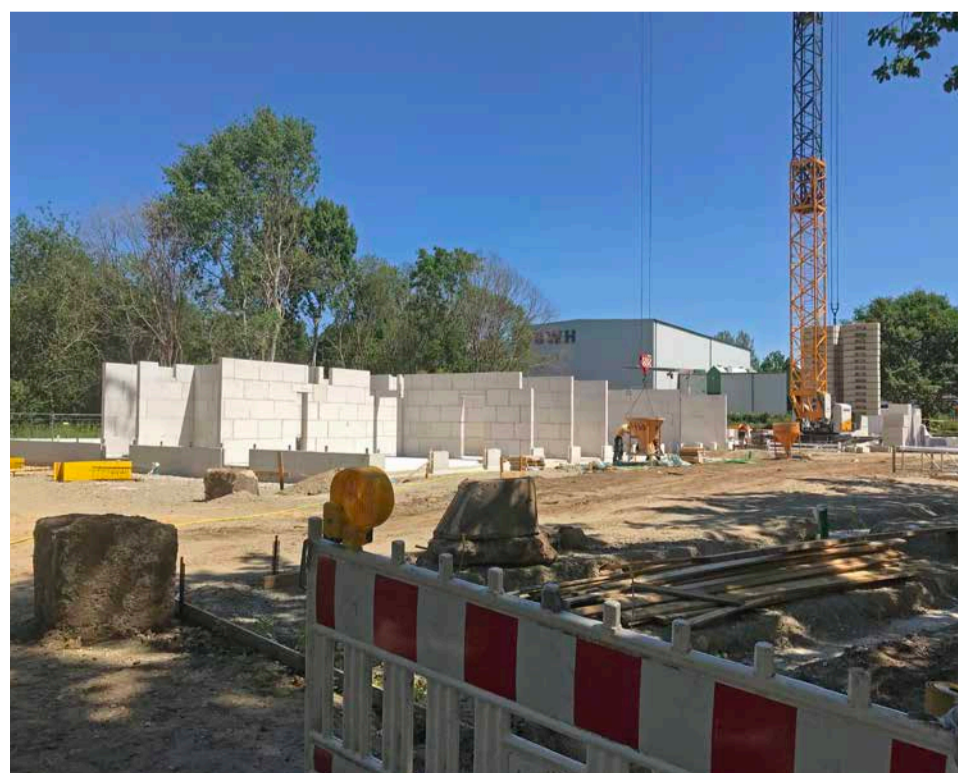
An der Beckstraße geht es beim Bau des neuen Familienzentrums sehr gut voran. Foto: LHH
