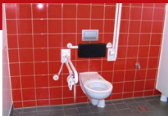
SCHULE IN DER STEINBREITE WC-SITZ MIT BEIDSEITIGEM FREIRAUM UND KLAPPBAREN STÜTZGRIFFEN MIT SPÜLUNG UND NOTRUF
