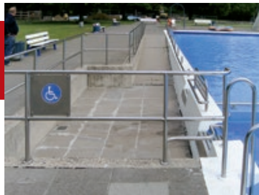
KLEFELDER BAD SEITLICH ANGELEGTE RAMPE
