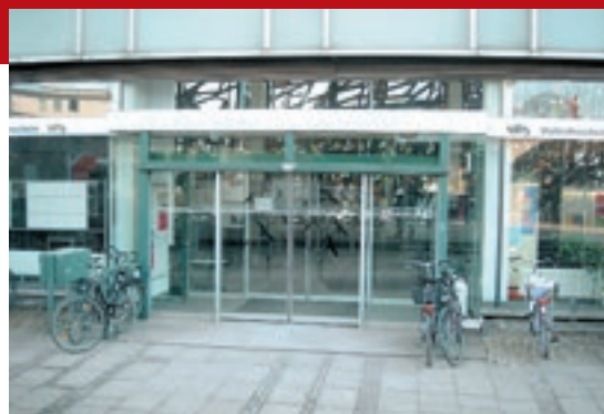
AUTOMATISCHE TÜRANLAGE MIT WINDFANG
