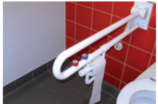
SCHULE IN DER STEINBREITE STÜTZGRIFF MIT SPÜLUNG UND NOTRUF
