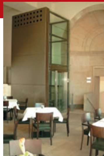
NEUES RATHAUS PERSONENAUFZUG IM GARTENSAAL
