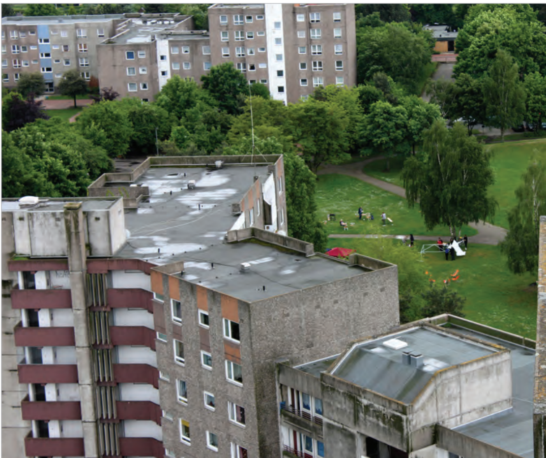
Blick auf den un- sanierten Bestand der Deutsche Wohnen SE und dem Stadtteilpark Schwarzwaldstraße (Christiane Gottwald)
