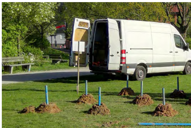
Oberflächensondierungen an einem Verdachtspunkt auf einer Rasenfläche (Foto: Feuerwehr Hannover)
