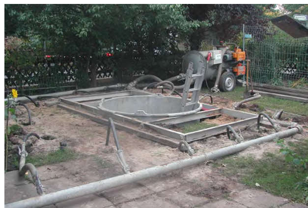
Baugrube mit Grundwasserabsenkung zur Sondierung einer Anomalie (Foto: KBD Niedersachsen)
