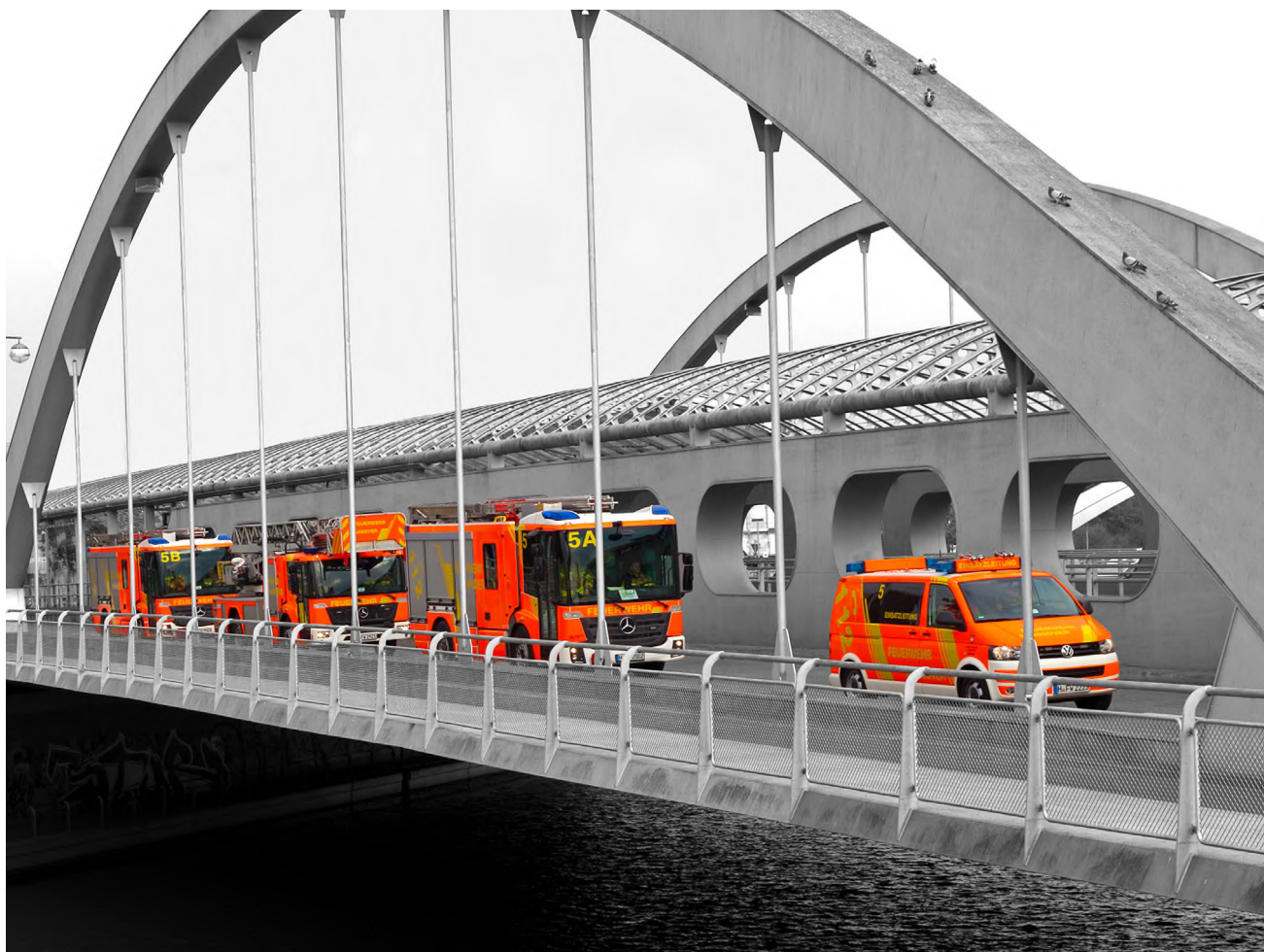
Ein Löschzug kreuzt den Mittellandkanal auf der Noltemeyerbrücke (Foto: Ulrich Reinecke)
