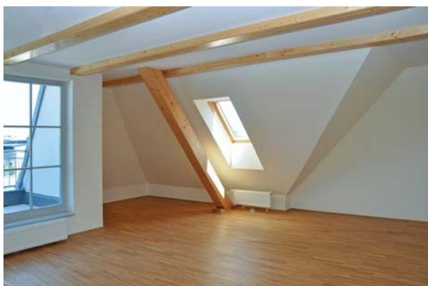
In Bereichen, die gemäß DIN 68800-1 den Gebrauchsklassen (GK) 0 bis 3.1 zuzuordnen sind (Innenräume von Wohngebäuden, tragende Hölzer, ausgebaute Dachgeschosse und ggf. auch Nassräume) ist auf chemischen Holzschutz zu verzichten und stattdessen sind baulich konstruktive Maßnahmen und geeignete Alternativverfahren anzuwenden.
