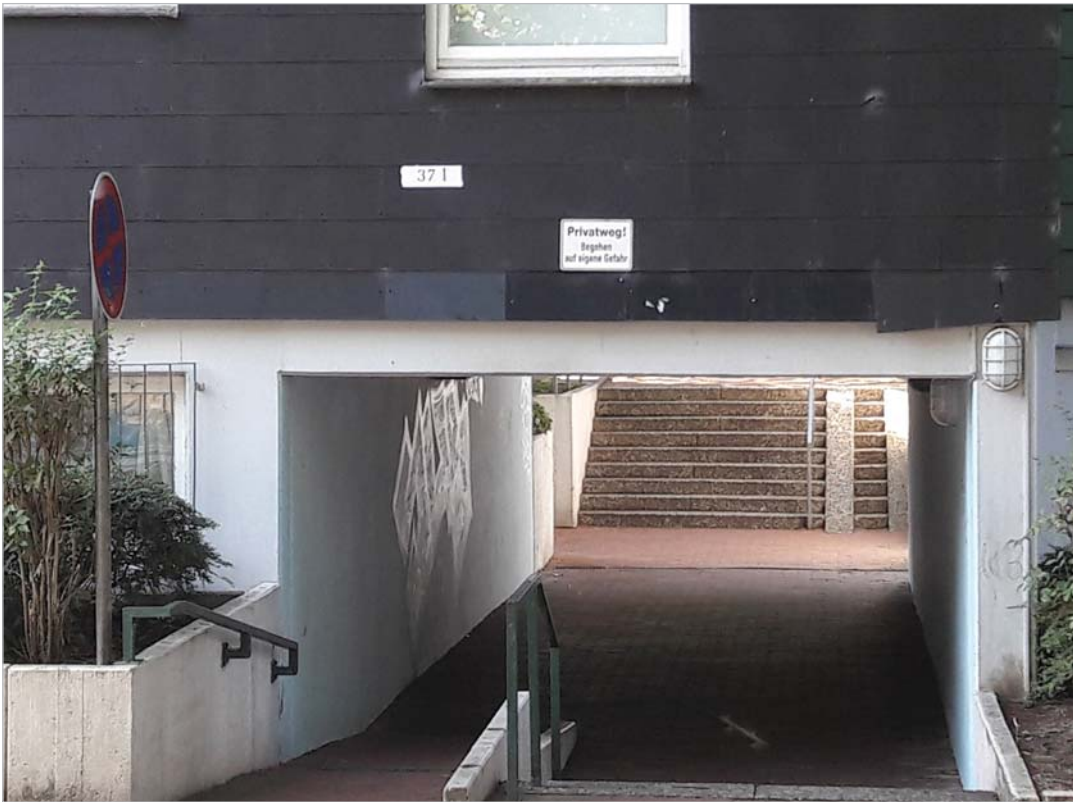
Durchgang mit Treppe und steiler Rampe (LHH)
