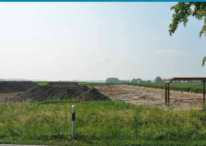
Abgeschobener Oberboden zu Mieten aufgesetzt
