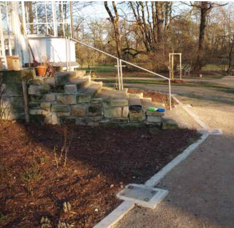
Mobiler Hochwasserschutz Hannover-Ricklingen
