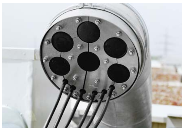
Abbildung 41: Ansicht der 1. Abdichtungsebene (Quelle: www.hauff-technik.de)
