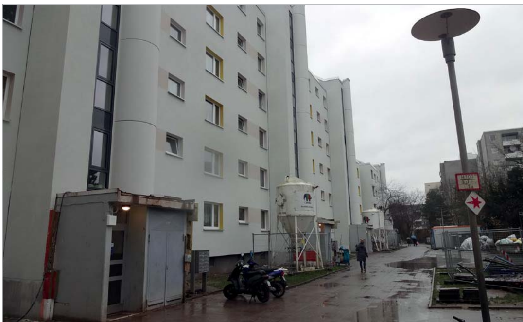
Modernisierung des Wohnbestandes im Spessartweg (Christian Leugner)
