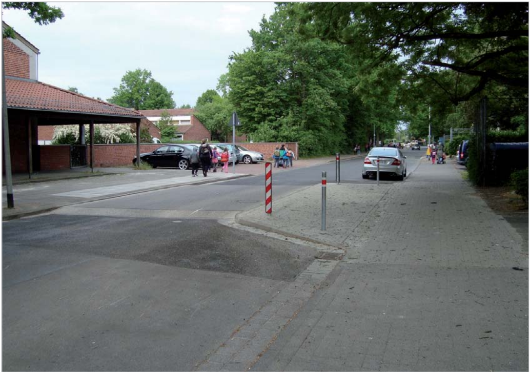
Umgestaltung einer Fußgängerquerung vor der Grundschule Hägewiesen (LHH)
