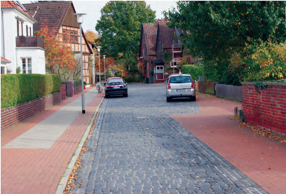
Twedenweg nach der Sanierung
