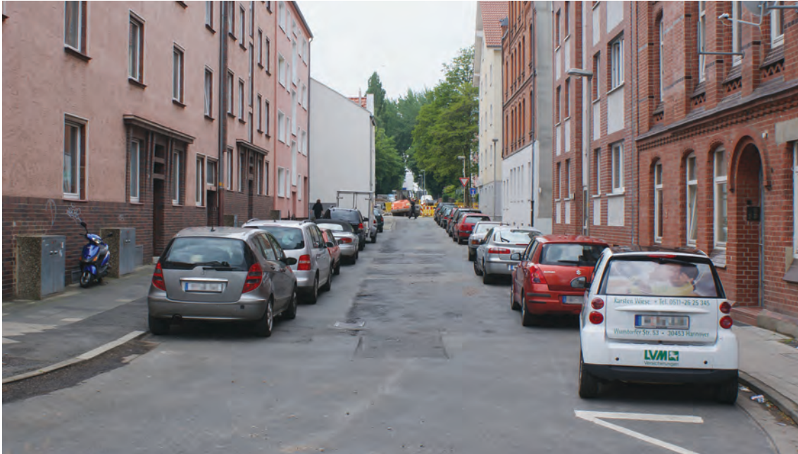
Kirchhöfnerstraße vor der Sanierung
