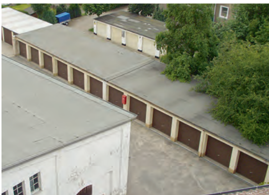
Hinterhofsanierung Wunstorfer Straße 97
