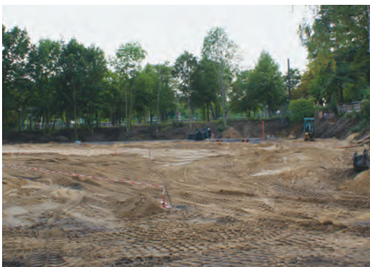
Bau des neuen Spielplatzes
