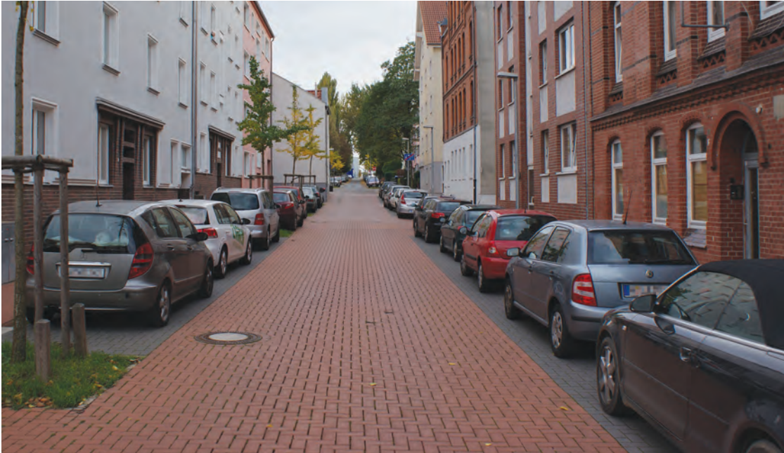
Kirchhöfnerstraße nach der Sanierung
