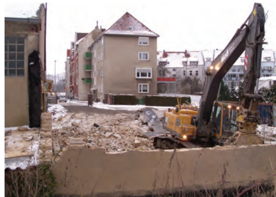
Abruch der KFZ-Werkstatt in der Steinfeldstraße
