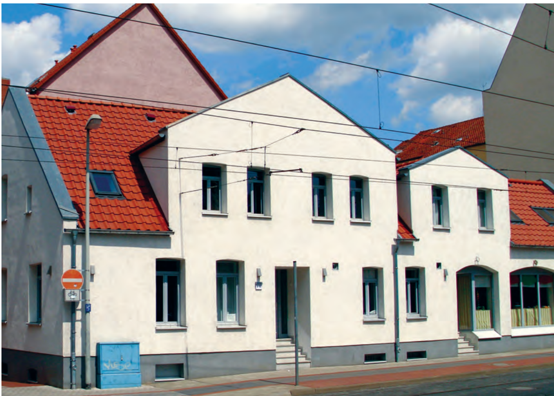
Harenberger Straße 8 - 10 vor und nach der Sanierung
