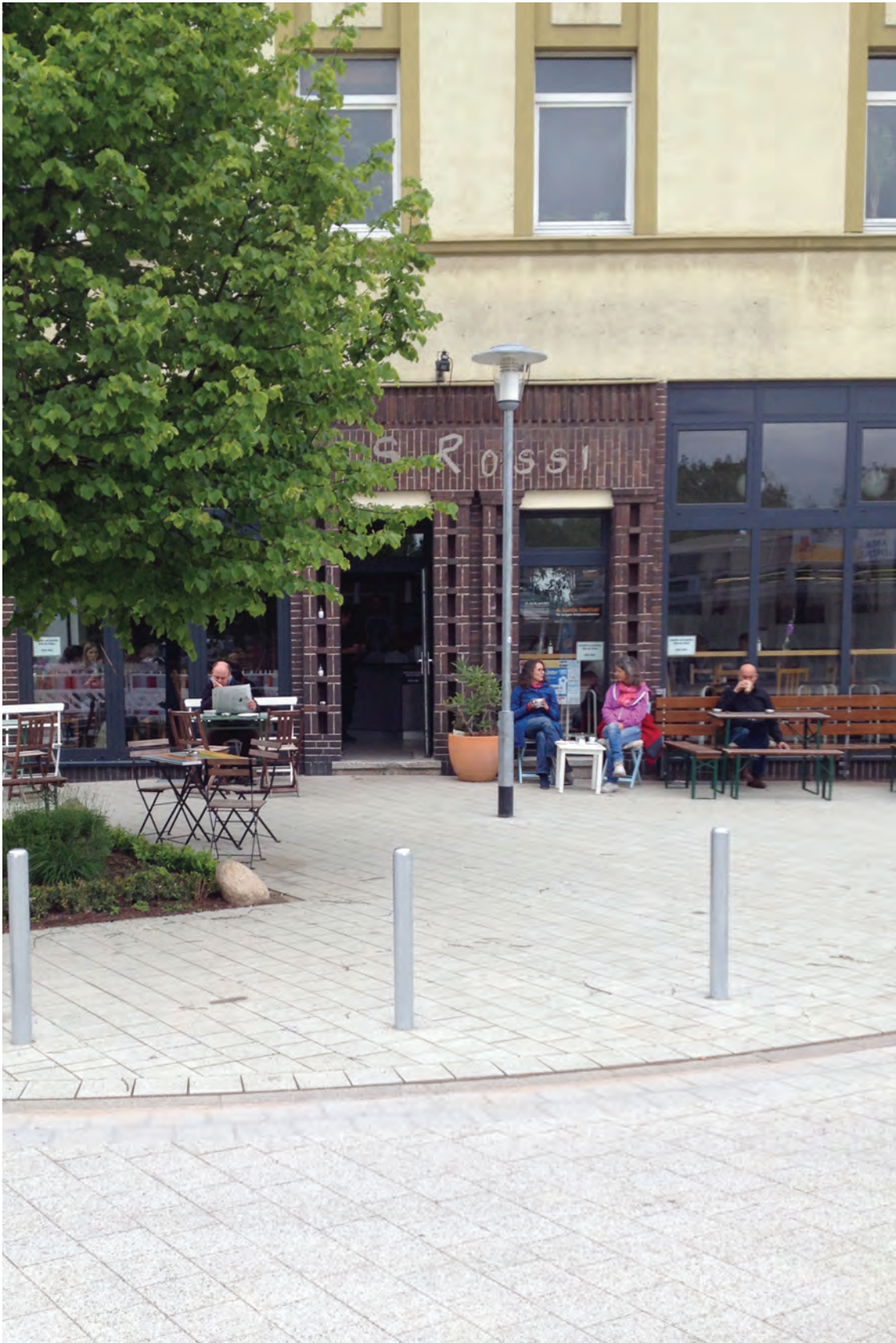
Franz-Nause Strasse nach der Sanierung
