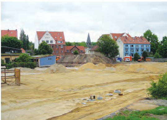
Baufelder während der Bodensanierung
