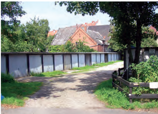
Alter Garagenhof in der Brunnenstraße
