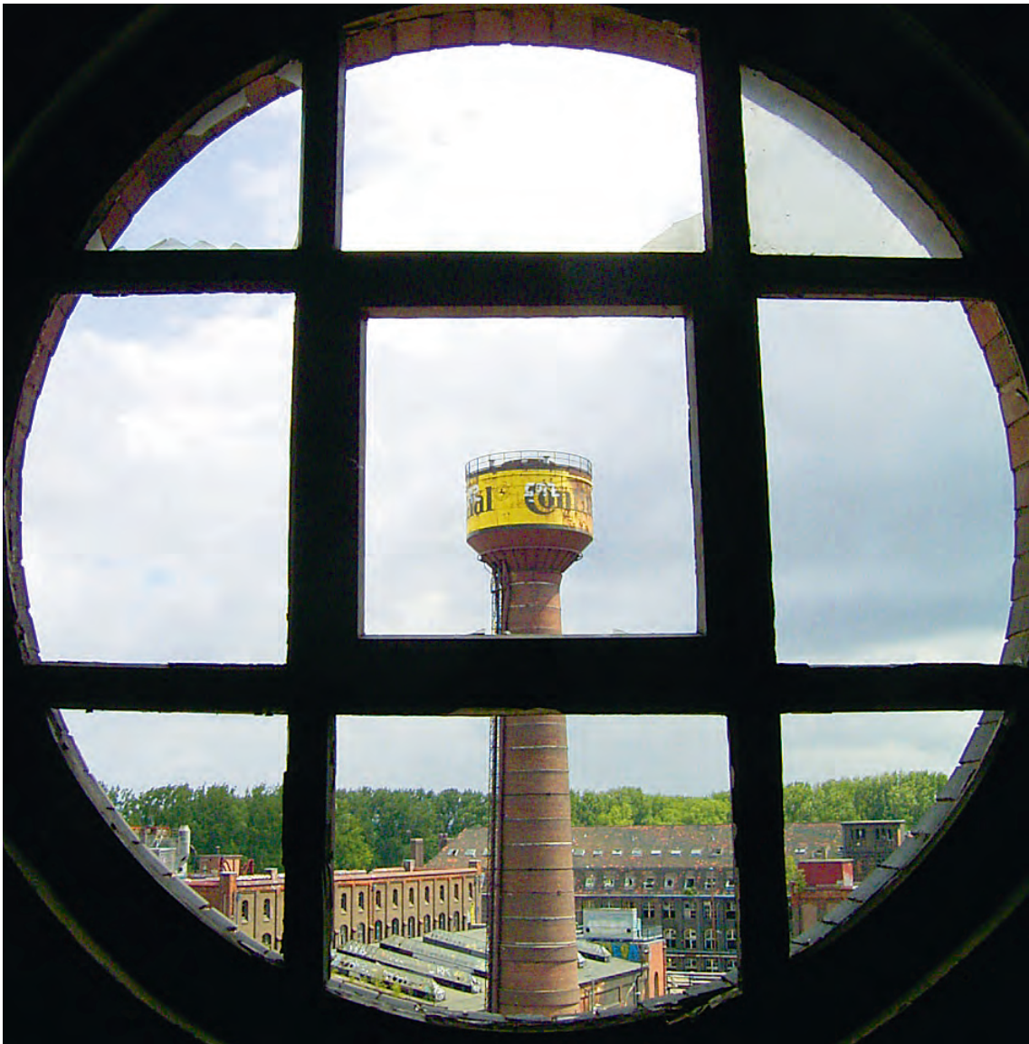
Der zum Wasserturm umgenutzte Schornstein und die Altgebäude aus ungewöhnlicher Perspektive
