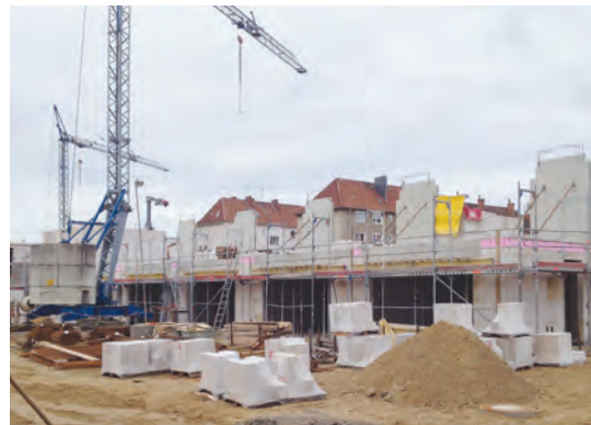
Bau der Reihenhäuser
