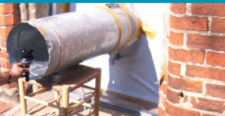
Kontrolle der Luftströmungsgeschwindigkeit
