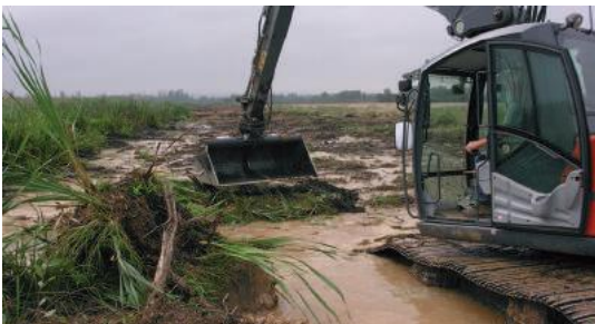
Baggern unter schwierigen Bedingungen: Anlage eines großen Flachwasserbereichs
