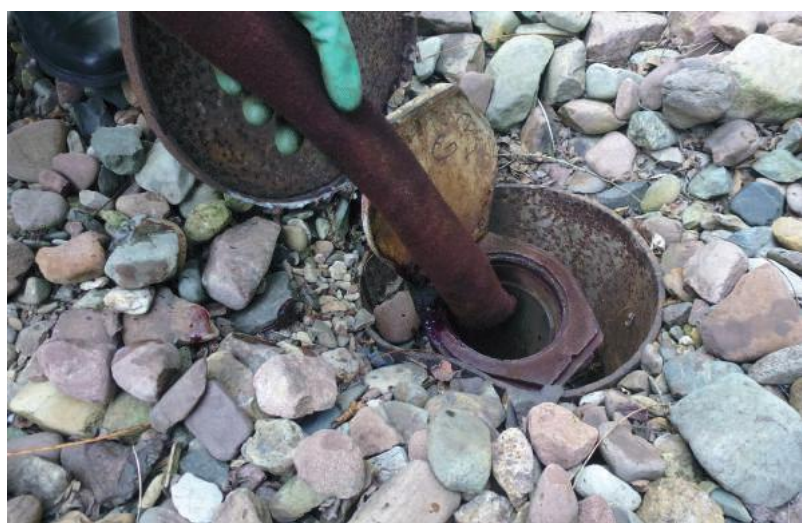
Befüllung des Strumpfes von Hand
