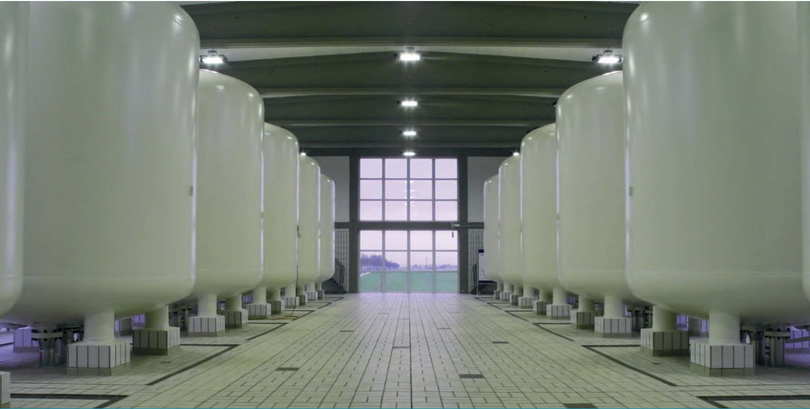
Wasserwerk Forst Esloh: Filterhalle (Quelle Wasserverband Garbsen-Neustadt)
