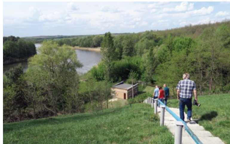
Pumpstation an der Wasserentnahmestelle am Fluss Ros: Der Geschäftsführer des Gifhorer Wasserwerks Manfred Gades besichtigt die Anlage in Begleitung des Direktors des Korsuner Wasserwerks Mykola Bardadym, des Chefindgenieurs Volodymyr Bereza und der Dolmetscherin Valentyna Dovhopola. © Rüdiger Wockenfuß
