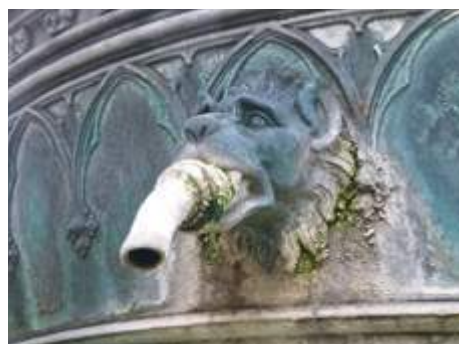
Detail vor und nach der Restaurierung
