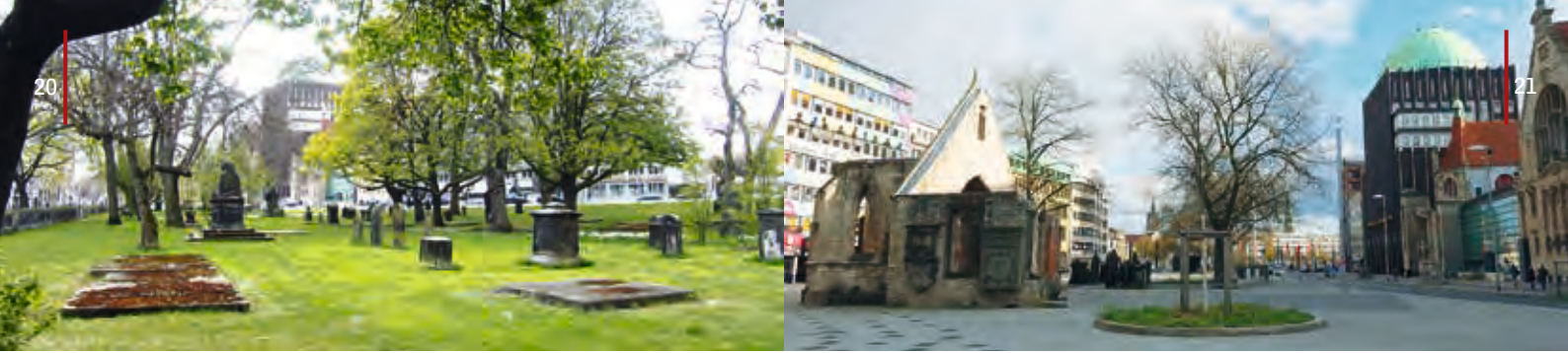
Der grün gestaltete Mittelteil des Parkfriedhofs wird in Richtung Westen schmaler und leitet an der Kapelle in den urbanen Stadtplatz an der Goseriede über
