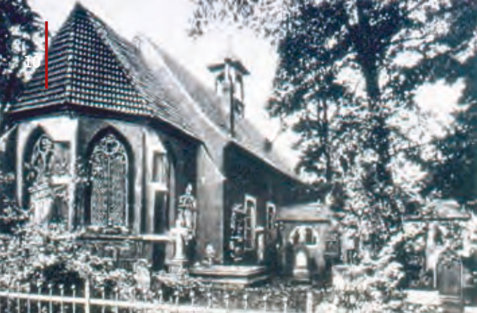
Die Kapelle in Blickrichtung Südwest etwa um 1927. Bereits damals hingen Wandplatten, sogenannte Epitaphien, an der nördlichen Außenmauer der Kapelle
