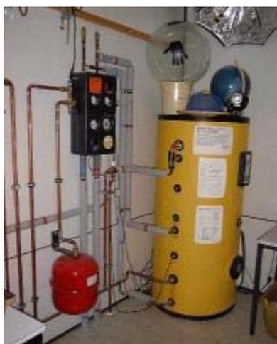
Ein Rechenbeispiel: Wenn das Speicherwasser von 20°C auf 80°C erhitzt wird, steckt darin eine Energie von rund 75 MJ (Megajoule). Das sind rund 21 kWh (Kilowattstunden).
