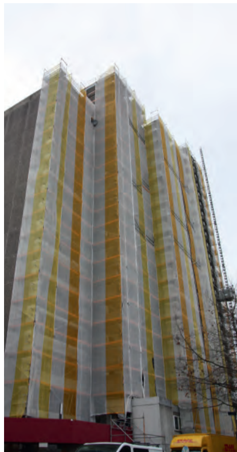
Am Hochhaus an der Elmstraße wurden in den vergangenen Wochen die Balkone saniert. Foto: Krings
