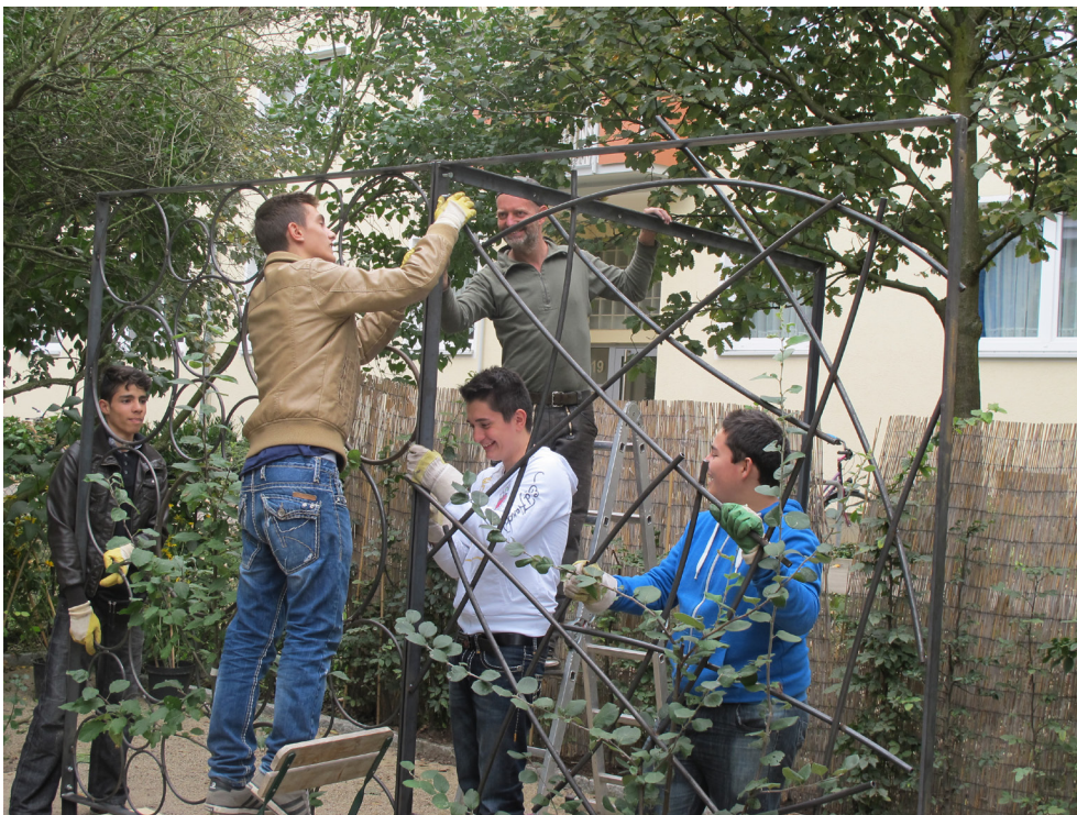
Jugendliche installieren ein Rankgitter im Rahmen einer Metallwerkstatt (Foto: Christina Glahn)
