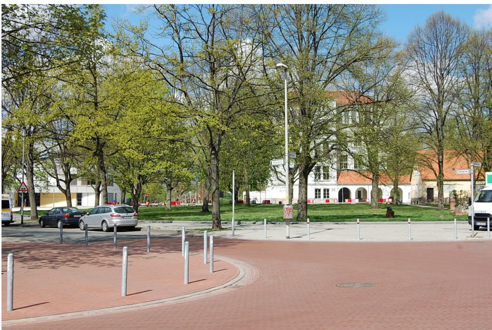
Die Kreuzung Bömelburgstraße/Voltmerstraße nach dem Umbau (Foto: Uta Schäfer)
