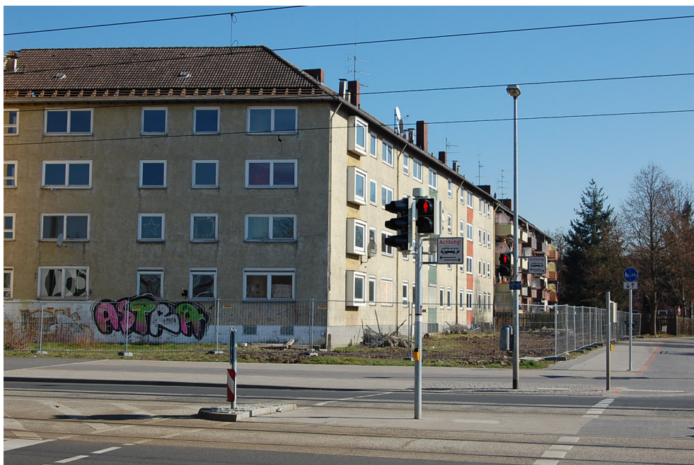
Das Bestandsgebäude kurz vor dem Abbruch (Foto: Uta Schäfer)
