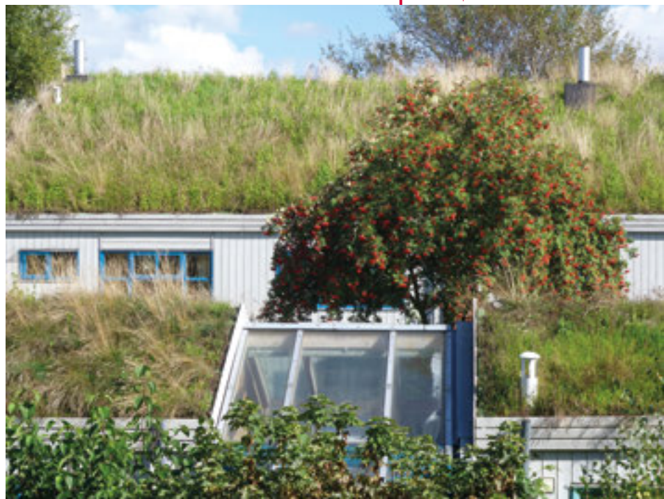
Die Grasdachsiedlung in Bothfeld | © Ulli Kowalke
