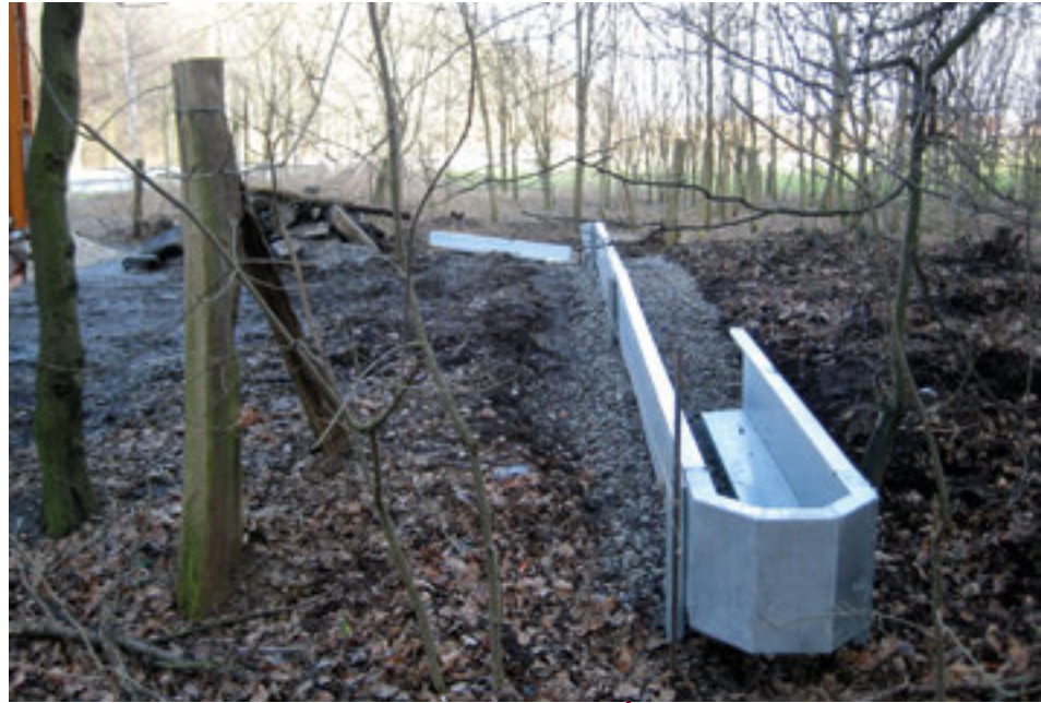
Amphibienleiteinrichtung entlang der Lenthaler Chaussee | © LHH
