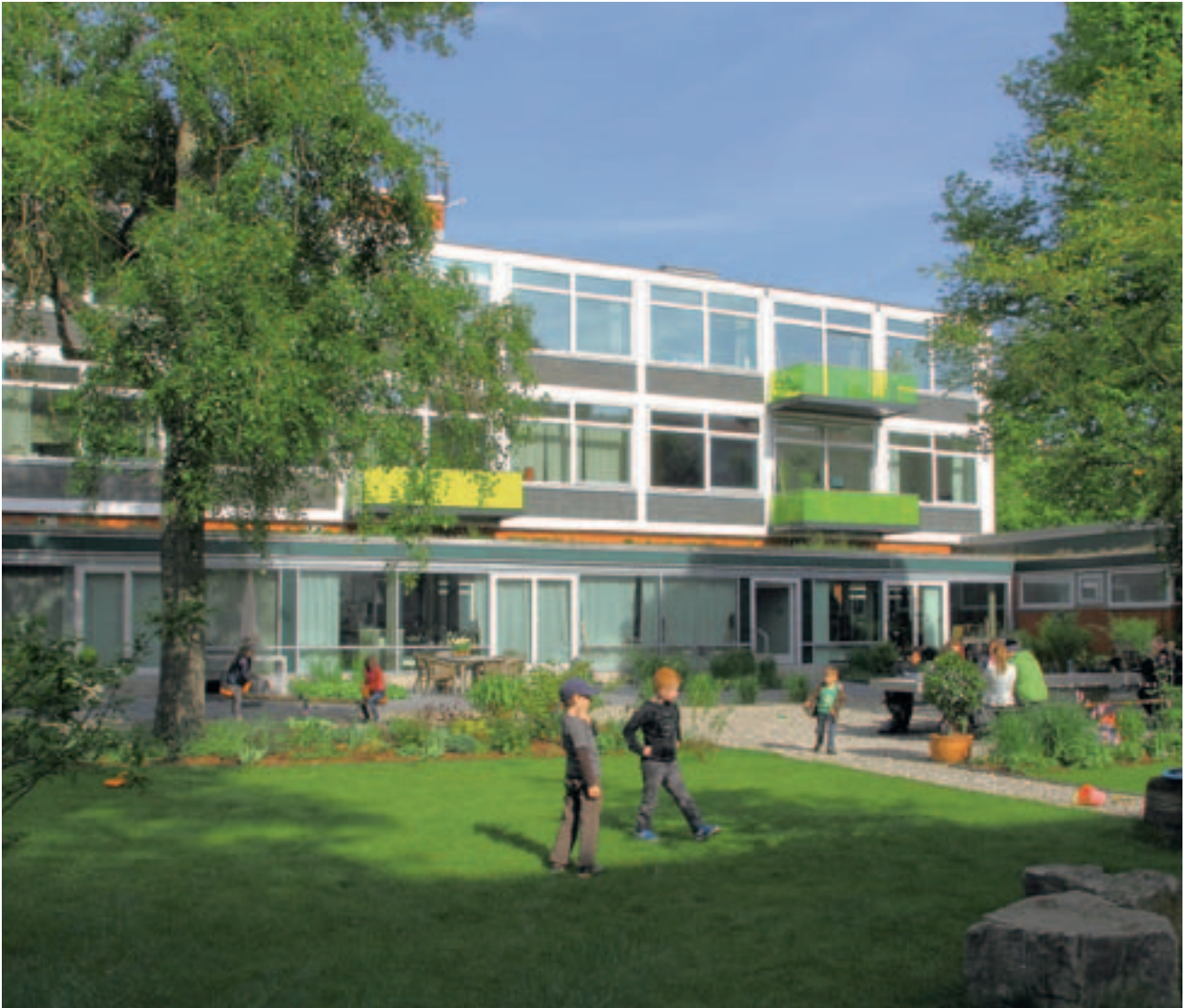
Zurück in die Zukunft. Umgebaute Moderne und gemeinschaftliches Wohnen in der Südstadtschule, Schlägerstraße. Architekt: Mosaik Architekten BDA
