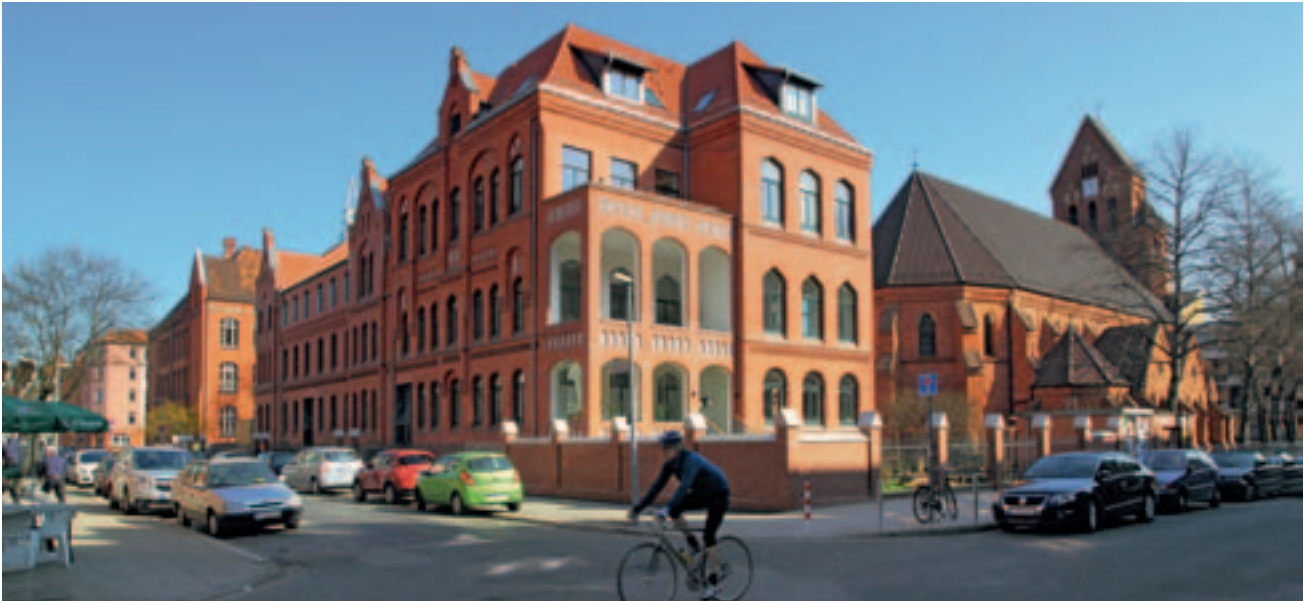
Das ehemalige katholische Alten- und Pflegeheim St. Josefstift in Linden wurde 2011 von einer Planungs-Gbr begonnen und beim Kauf zu einer Baugemeinschaft umgewandelt. Es ist ein Haus der vielen Perspektiven mit gut funktionierenden Nachbarschaften für Alt und Jung. Architekt: k + a_architekten
