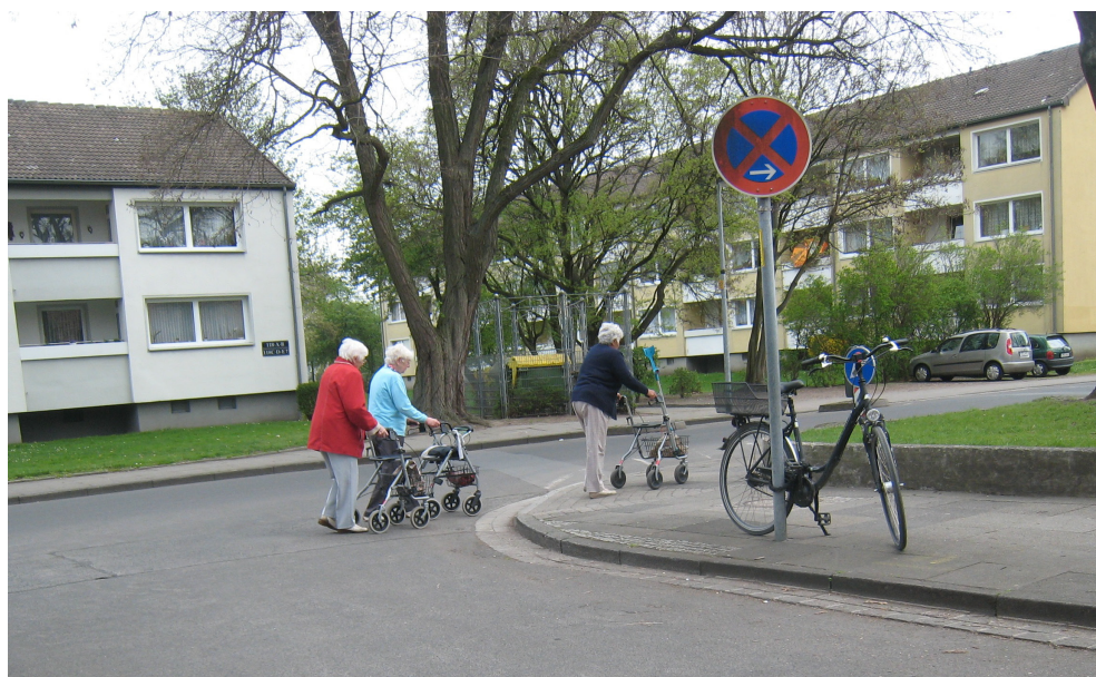
Bordsteinabsenkung als Maßnahme für Barrierefreiheit
