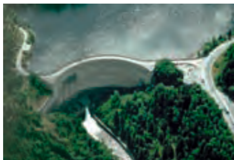
Die Talsperren und Hochwasserrückhaltebecken im Harz dienen auch dem Hochwasserschutz. Bei kurzzeitigen Starkregenereignissen können sie die Wassermengen auffangen und dosiert wieder abgeben. Flutwellen lassen sich dadurch deutlich abmildern.
