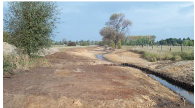
Bild 3: Laher Graben, Standort Waidkampsheide, direkt nach Fertigstellung, Okt 2005 (Geschwungener MW-Profilverlauf, Aufweitungsbereiche)
