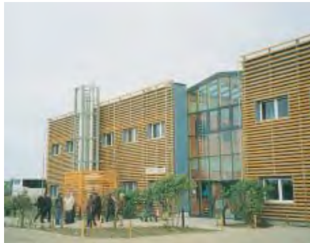
Heizzentrale mit BHKW heating centre with decentral CHP
