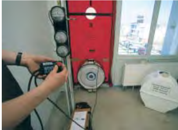
Prüfung der Luftdichtheit checking airtightness
