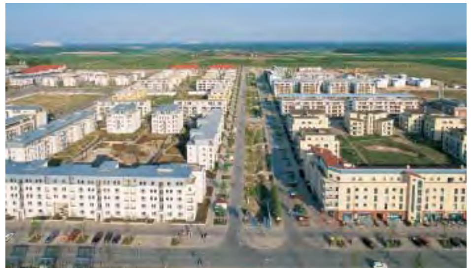
Erster Bauabschnitt: Kronsberg-Mitte aus westlicher Richtung structure of the first construction phase: Kronsberg Central from the west
