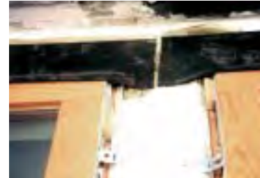
Bild 3: Abdichtung der Fensterfuge mit doppelseitigem Butylklebeband und Spritzkork.
