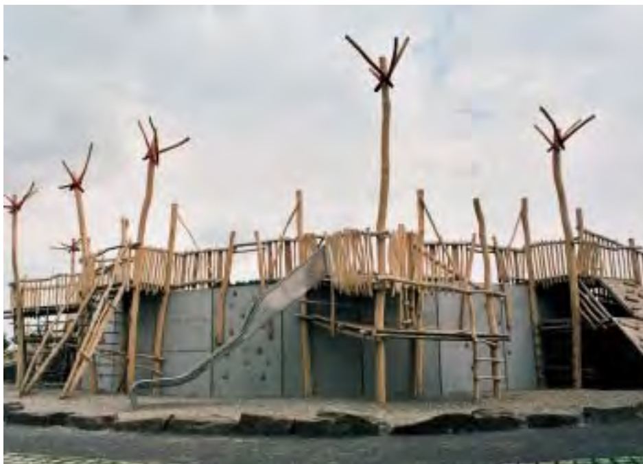
Öffentlicher Spielplatz auf dem Wärmespeicher / playground above the heat storage tank
