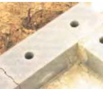
Bild 1: Kimmschicht aus wärmedämmenden, künstlichen Steinen.
