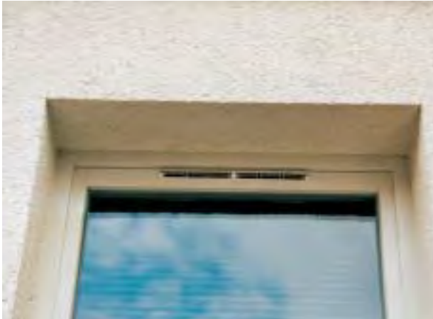
Zuluftöffnung / ventilation slit
