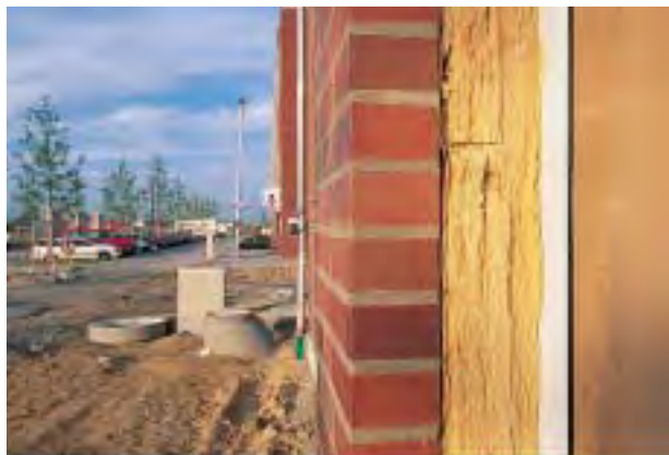
2-schaliges Mauerwerk mit Kerndämmung cavity wall insulation
