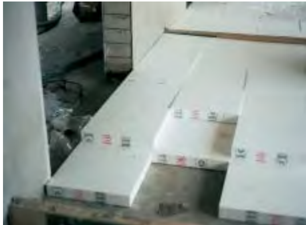
Dämmung im Fußbereich foundations insulation
