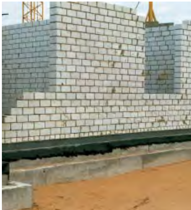
Die erste Steinschicht im Sockelbereich wurde mit einem hochdämmenden Stein gemauert. The first course of masonry in the base was laid with superinsulating stone.
