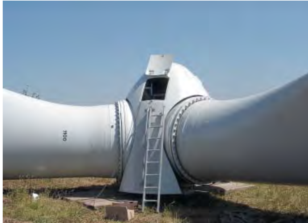
Rotor im Bau rotor under construction
