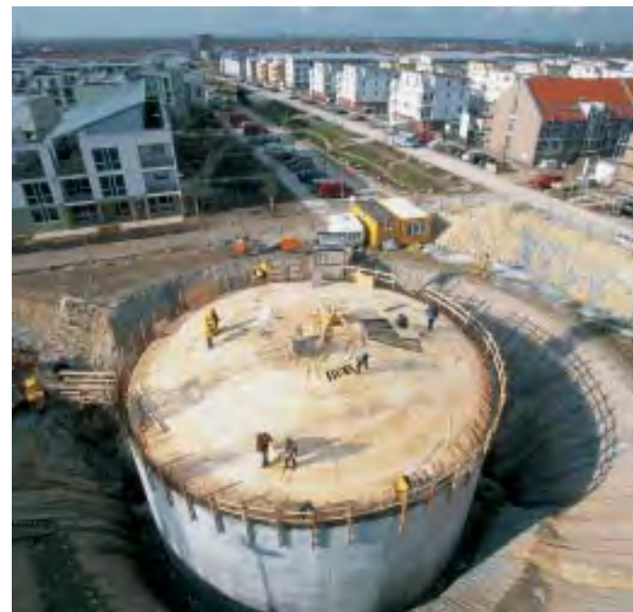
Speicher im Bau / tank under construction
