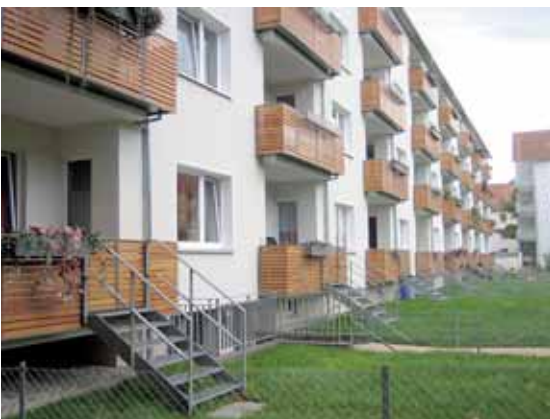
Sanierung im Geschosswohnungsbau in Hannover-Vahrenwald Refurbishment in the apartment block in Hannover-Vahrenwald
