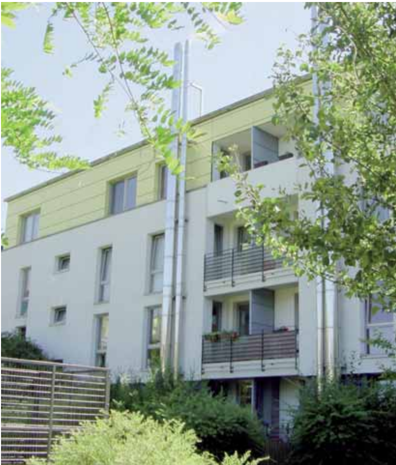
BHKW im Keller eines Wohnhauses CHP in the cellar of an apartment building
