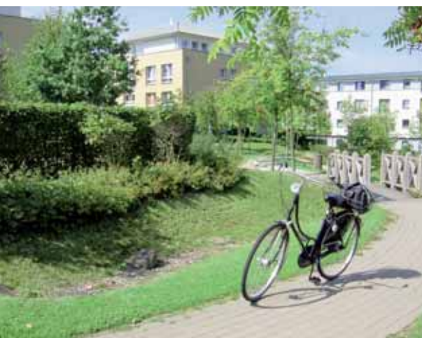
Mulden-Rigole im privaten Bereich Hollow-trench in a private area
