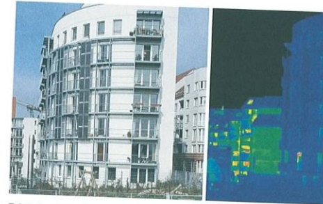
Erfolgskontrolle über Thermografie-Messung und Unterdruckprüfung
