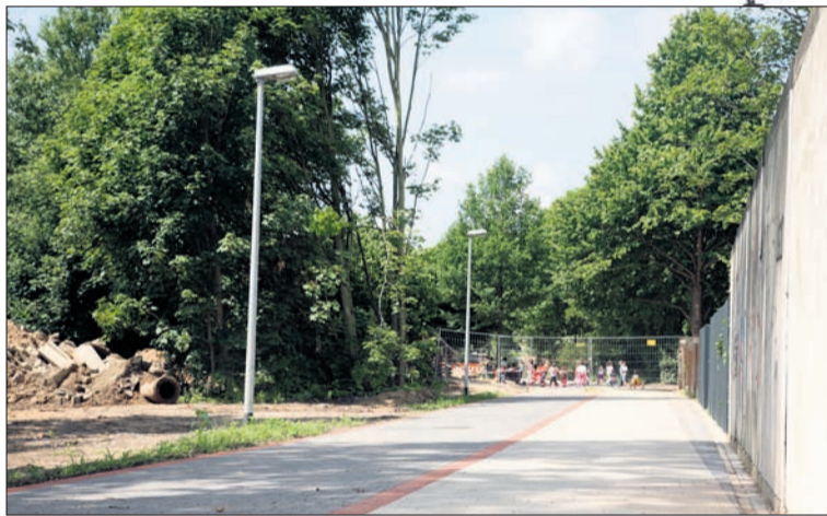
In Arbeit: Teile der neuen Fuß- und Radwegeverbindung von der Voltmerstraße zur Schulenburg-Landstraße sind bereits fertiggestellt.
