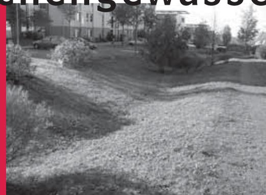
Mulden-Rigolen-System zum Zwecke der Grundwasseranreicherung
