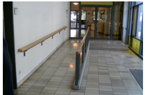
PESTALOZZI-GRUNDSCHULE RAMPE IM FLUR
