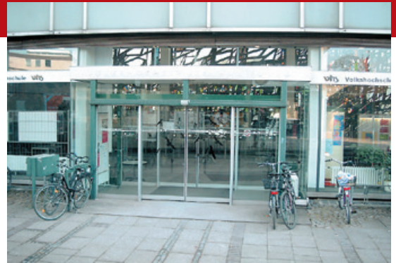
AUTOMATISCHE TÜRANLAGE MIT WINDFANG
