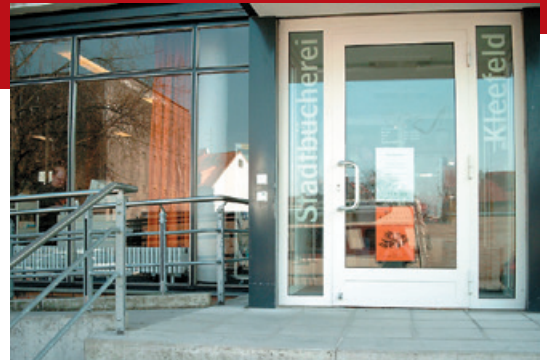
STADTBIBLIOTHEK KLEEFELD EINGANG MIT AUTOMATISCHER TÜRANLAGE
