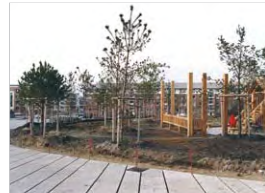
Quartierpark Nord, vor der Fertigstellung
