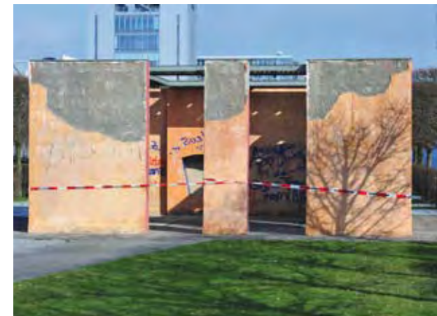
Nach der EXPO: Vandalismus im Pavillon
