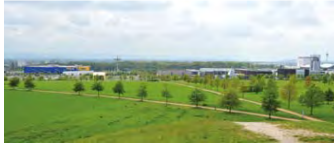
Das EXPO-Ost-Gelände heute
