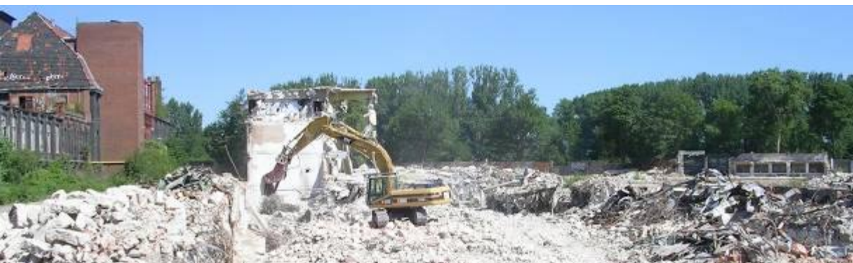
Abbruchmaßnahmen auf dem Gelände der Wasserstadt
