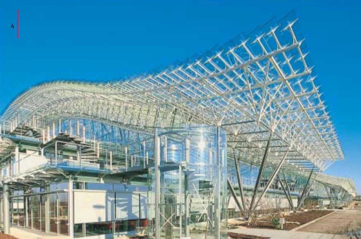
! SCHÖNE ORTE, FASZINIERENDE ARCHITEKTUR: VERWALTUNGSGEBÄUDE DER DVG AM KRONSBURG
