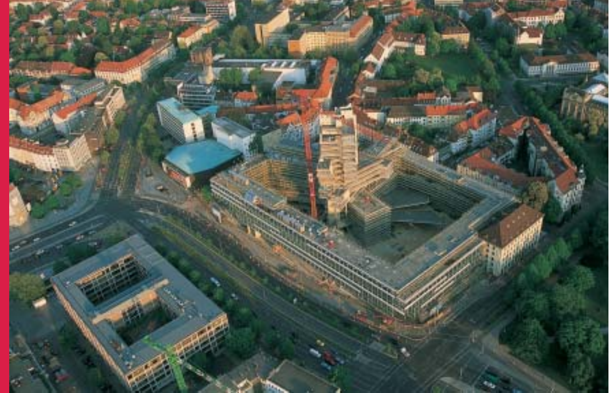
URBANITÄT IM GRÜNEN: BAUSTELLE DER NORD/LB AM FRIEDRICHSWALL
