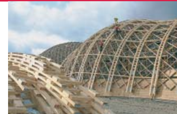
! JAPANS PAVILLON WIRD NACH DER EXPO RECYCLED
