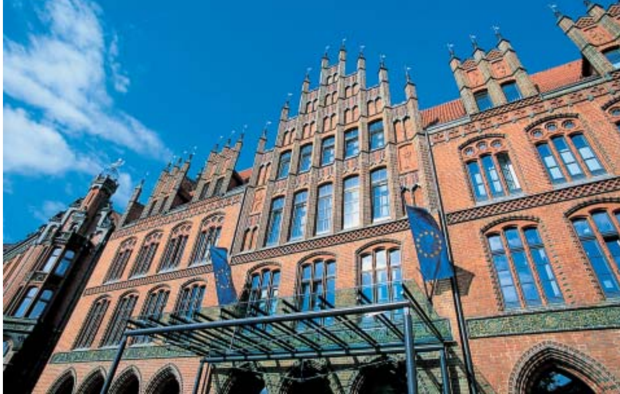
| NEUES LEBEN: DAS ALTE RATHAUS MIT NEUEM INNENHOF
