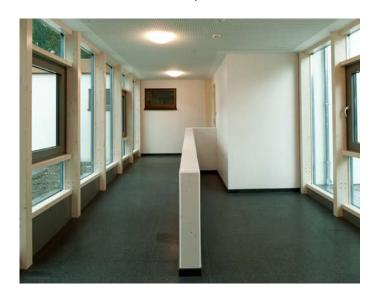
Anstelle des bisherigen Obergeschossaufbaus wurde die Decke des darunter befindlichen zentralen Ess- und Aufenthaltsraums angehoben. Das neue erhöhte Pultdach ermöglichte den Einbau eines Fensterbands, was dem Raum viel Luft und Licht gibt.
