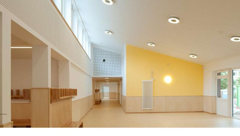
Besonderes Augenmerk wurde auf eine verbesserte Akkustik gelegt: Schallschluckende Wand- und Deckenpaneele sorgen für einen gedämpften Geräuschpegel im gesamten Gebäude.
