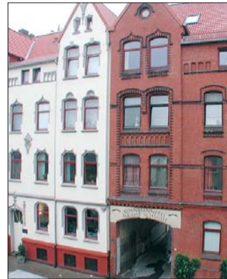
Links verputzt, rechts detailgetreu saniert – das ursprüngliche Fassadenbild wollte der Eigentümer erhalten.
