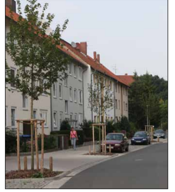
Der erste Abschnitt ist fertig.
