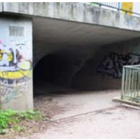
Unterquerung der B 6
