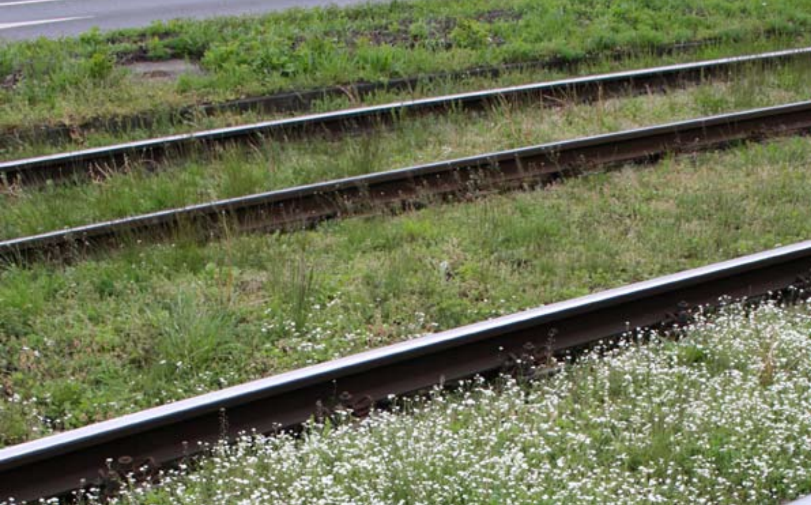
Gleisbett der Stadtbahnlinie 4 entlang der B 6
