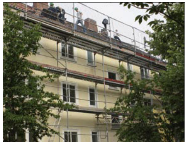
Auch das Dach wird umfassend saniert. Dadurch soll der Energieverbrauch sinken.
