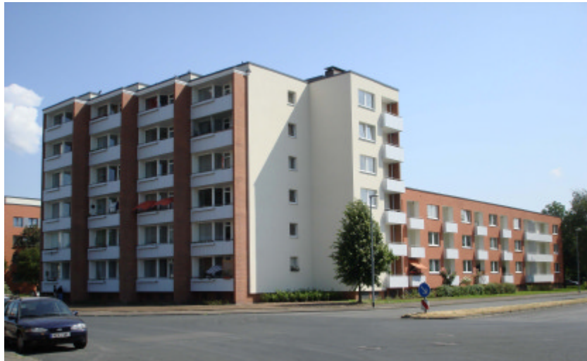
Dunantstraße/Holzwiesen - 63 Wohnungen wurden modernisiert -
