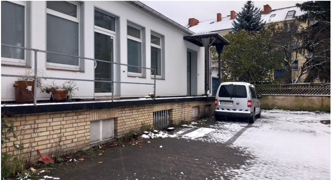
Foto 03: Blick auf das Gebäude der Weißenburgstraße 2a
