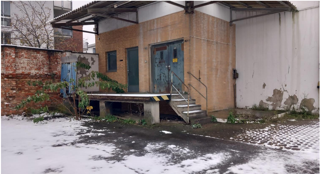
Foto 27: Laderampe am nördlichen Ende des Gebäude Elisabeth-Granier-Hof 5
