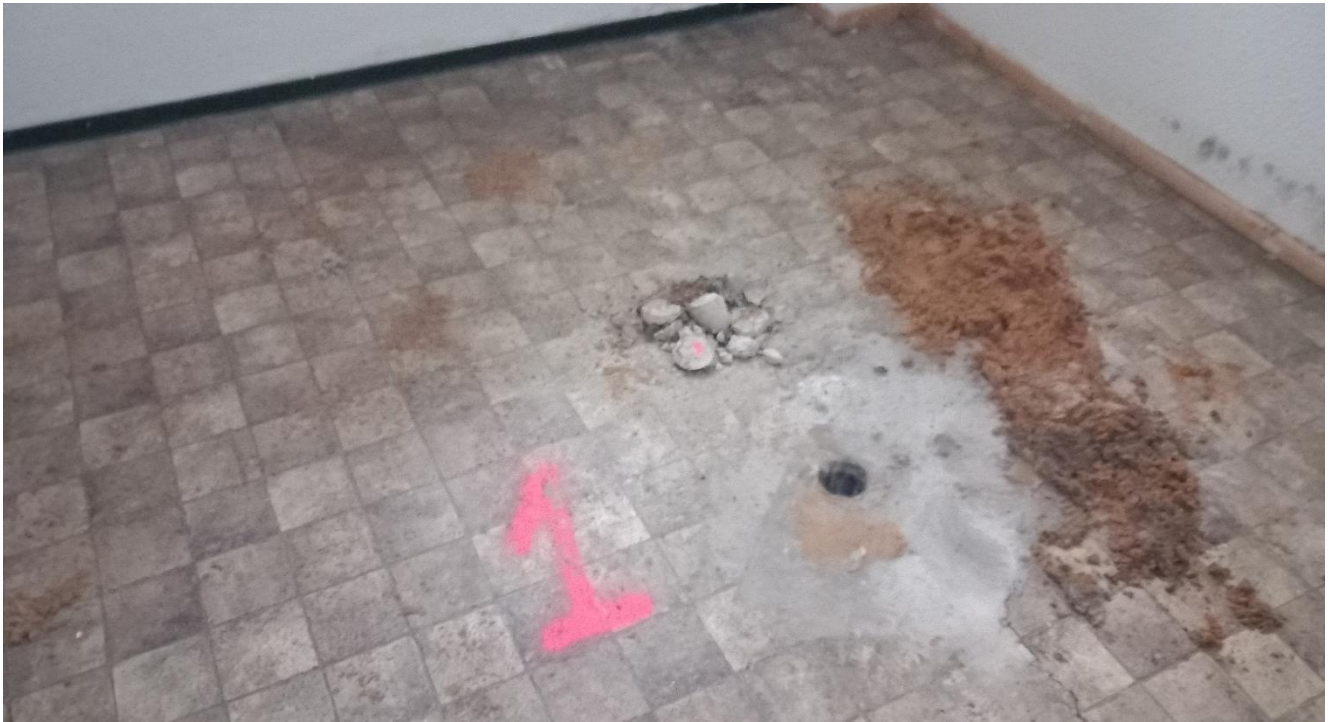
Foto 39:: Bohrung 1 im Gebäude Elisabeth-Granier-Hof 5
