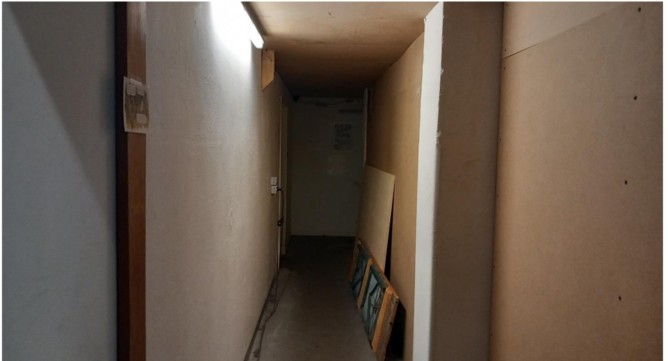
Foto 05: Flur Innenraum Weißenburgstraße 2a
