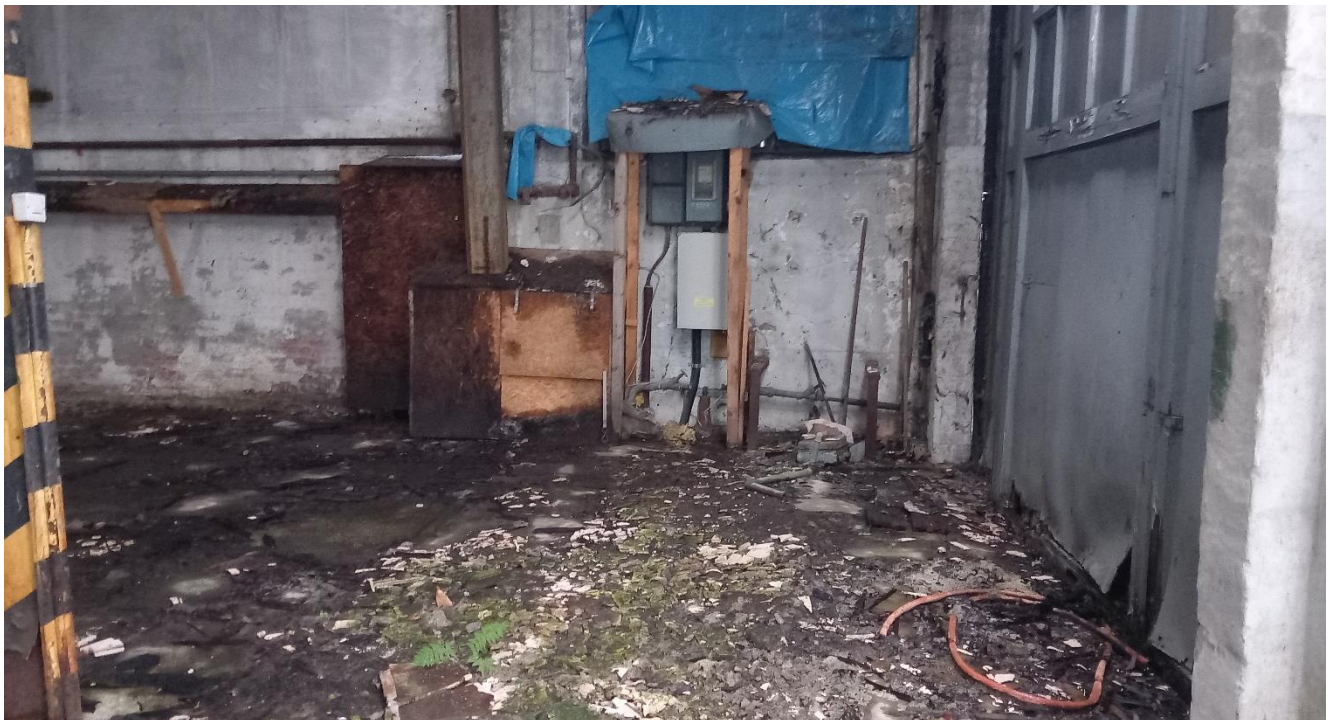
Foto 26: Innenbereich der Halle am nördlichen Ende des Parkplatzes von Elisabeth-Granier-Hof 5
