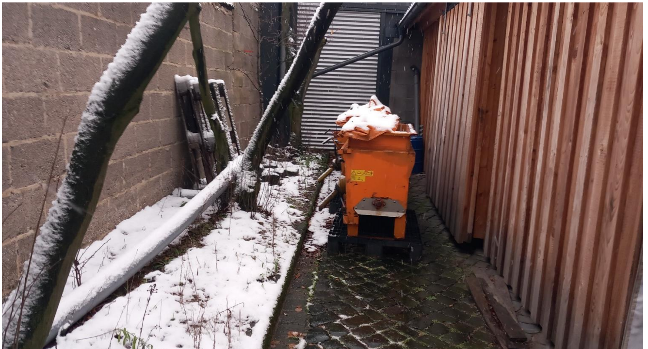
Foto 20: Blick hinter den Carport Elisabeth-Granier-Hof 3
