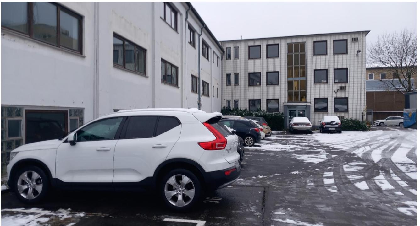
Foto 32: Blick auf den Eingang vom Gebäude Elisabeth-Granier-Hof 5
