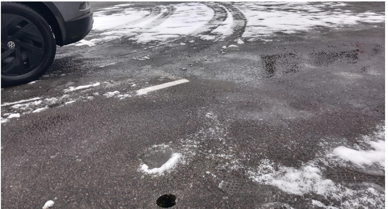
Foto 30: Kernbohrung auf dem Parkplatz Elisabeth-Granier-Hof 5
