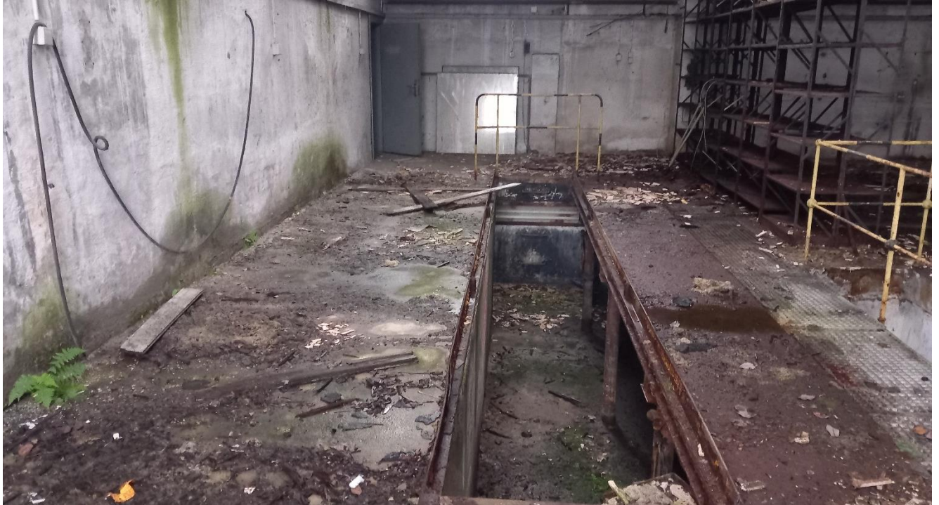
Foto 25: Innenbereich der Halle am nördlichen Ende des Parkplatzes von Elisabeth-Granier-Hof 5
