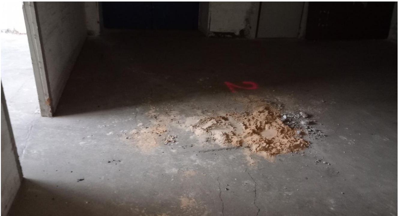
Foto 40:: Bohrung 2 im Gebäude Elisabeth-Granier-Hof 5
