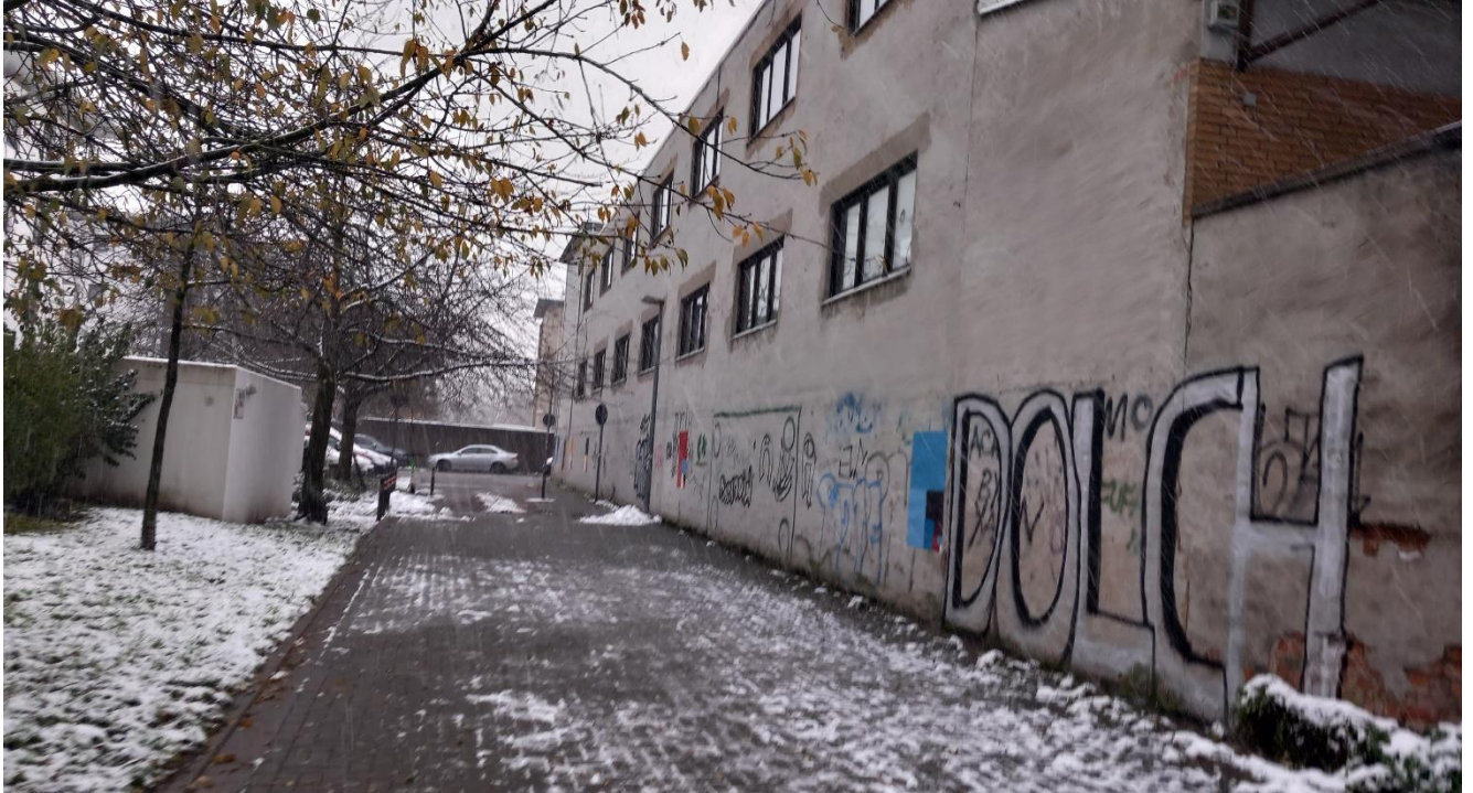
Foto 11: Außenansicht des Gebäudes Elisabeth-Granier-Hof 5
