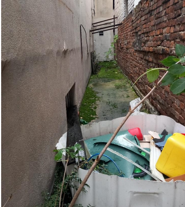
Foto 09: Bereich hinter dem Gebäude Weißenburgstraße 2a. Grenze zum Elisabeth Granier Hof 5. Blickrichtung nach Osten
