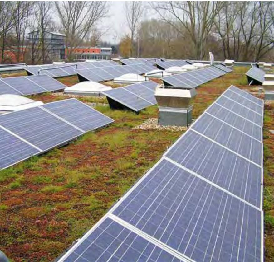
Abb. 19: Auf dem Dach des Werkhofes Stammestraße wurde zusätzlich zur Dachbegrünung eine Photovoltaikanlage installiert.
