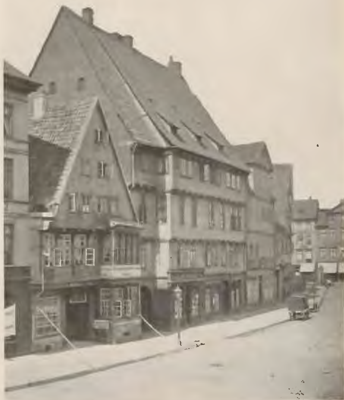
Häuser an der Dösterstraße (O 275 ff.) vor dem Durchbruch der Grubenstraße.
