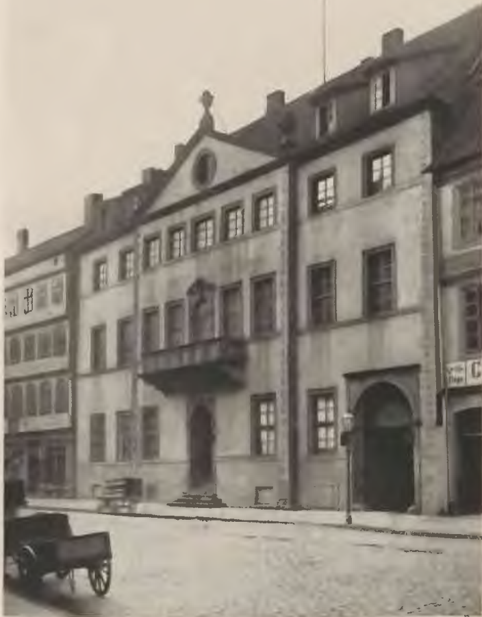
Amtsgericht an der Osterstraße (O 263), vordem v. Redenscher Hof, zuletzt Gasanstalt.
