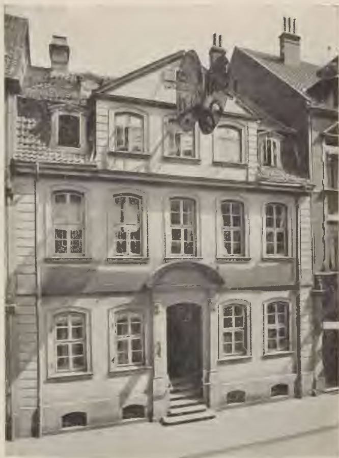
(Abb. 1.) Wohnhaus des Festungsbaumeisters G. J. Dinglinger (jetzt Große Megdienstr. 32).
